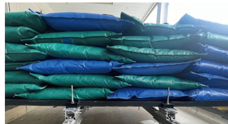
ソーラーパネル及び補強架台の荷重検証風景
